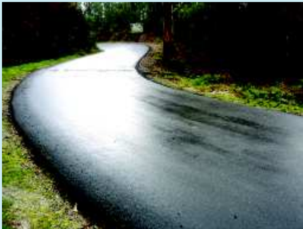
Pavimentação de troço da E.M. n.º 559 SUL - S. MARTINHO DAS MOITAS
