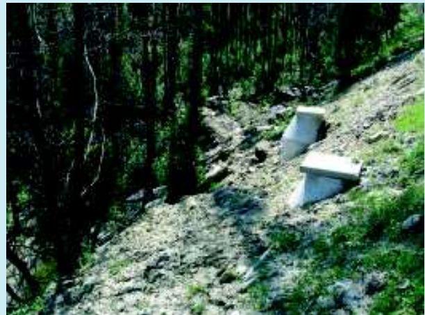
Obras de condução de águas pluviais VALADARES
