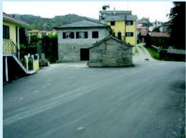
Obras de saneamento básico Fase final (construção de fossa) COELHEIRA
