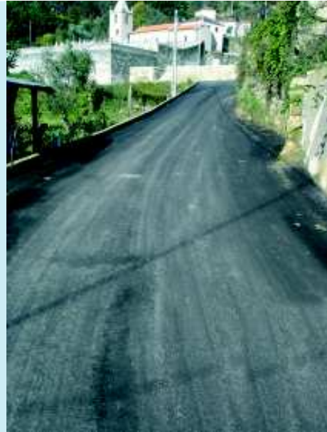
Pavimentação de ruas VALADARES
