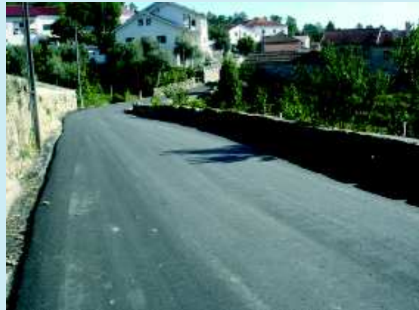
Pavimentação de ruas em Goja VILA MAIOR
