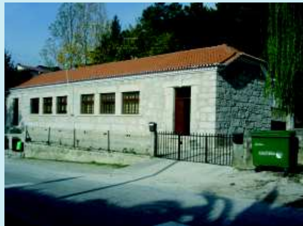
Obras de manutenção da Escola PINDELO DOS MILAGRES
