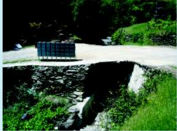
Beneficiação/reparação de pontão, Fajaco SUL
