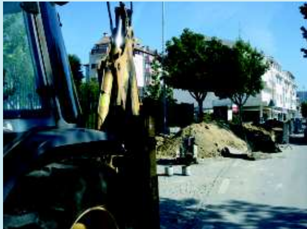
Obras de saneamento S. PEDRO DO SUL
