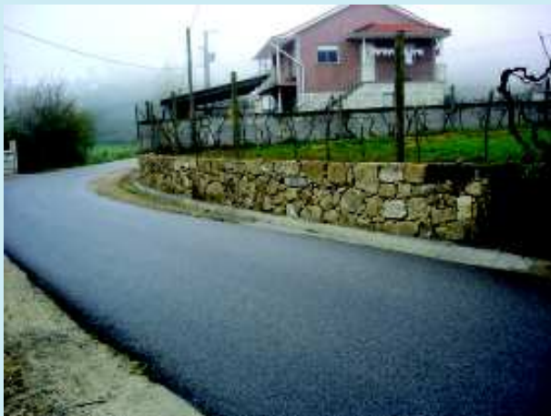
Alargamento, construção de muros e valetas SERRAZES
