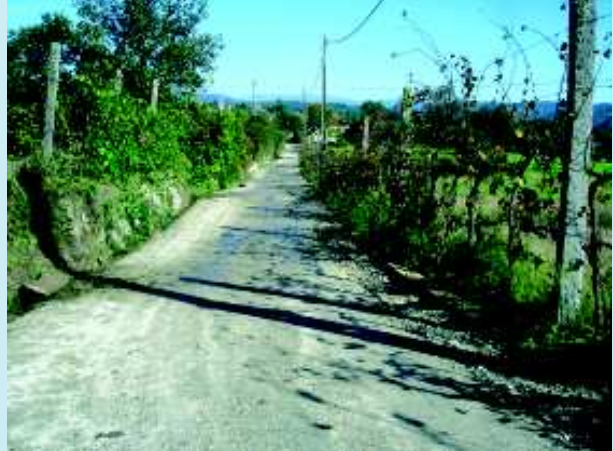
Saneamento e pavimentação em Nogueira - Paço BORDONHOS
