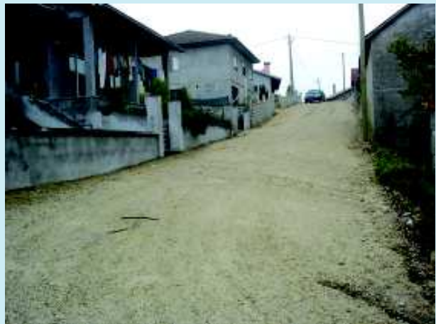
Reparação de ruas, Bairro Moinhos de Vento SERRAZES
