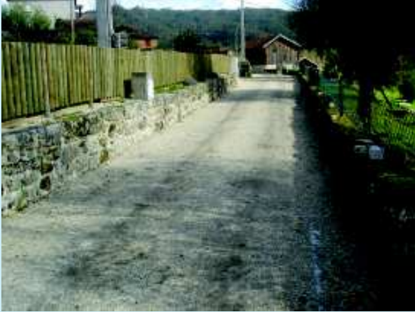
Calçetamento de ruas SUL
