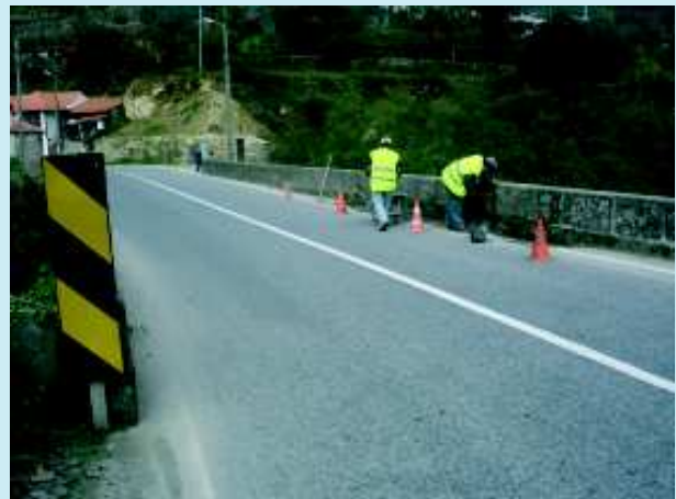
Reparação na Ponte (Rio Vouga) S. PEDRO DO SUL
