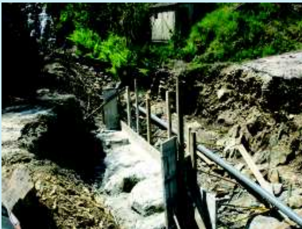
Construção de pontão, Deilão COVAS DO RIO
