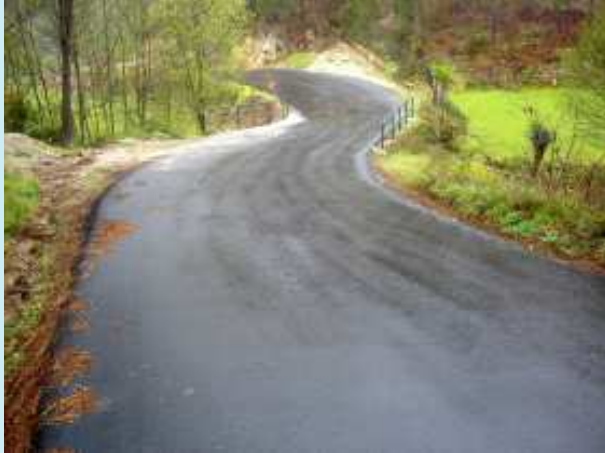
Pavimentação da estrada de Janarde SANTA CRUZ DA TRAPA
