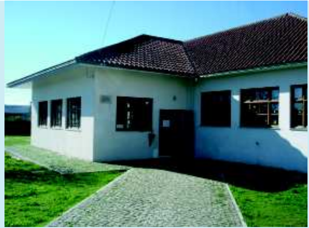
Obras de manutenção do Jardim-de-Infância SANTA CRUZ DA TRAPA
