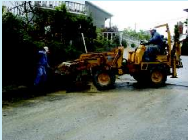
Execução de valetas, Sendas VILA MAIOR
