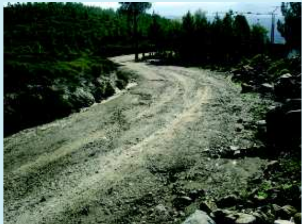
Manutenção de diversos estradões no concelho
