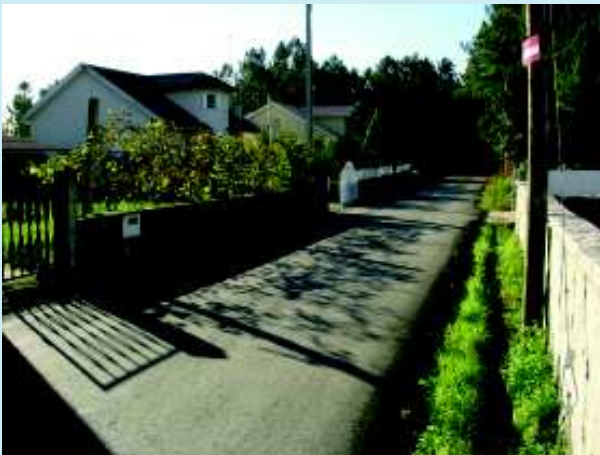
Pavimentação de estrada em Mourel CARVALHAIS
