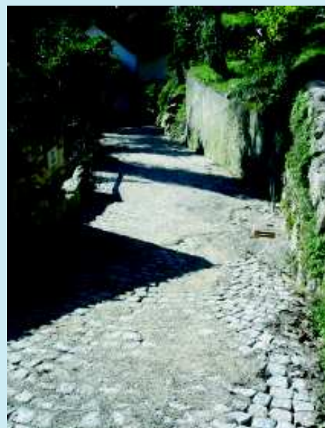
Calcetamento da Rua da Latinha S. CRISTÓVÃO DE LAFÕES
