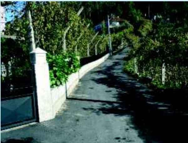
Pavimentação de estrada no Chão do Coto VALADARES
