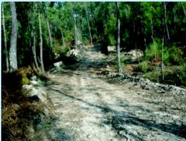
Abertura de estradão florestal FIGUEIREDO DE ALVA
