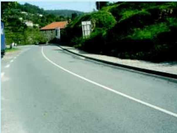
Construção de passeios S. PEDRO DO SUL
