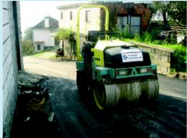
Pavimentação de ruas no Sobral PINHO
