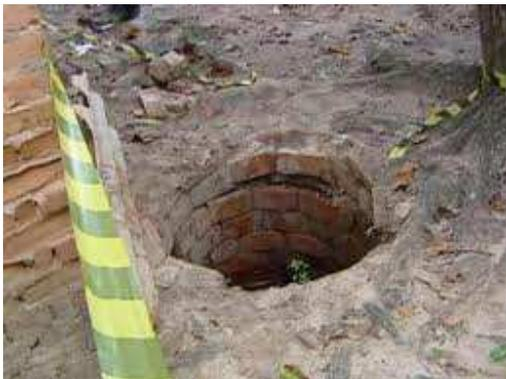
Figura 20 – Poço sem cobertura ou resguardo eficaz
