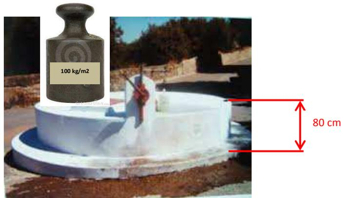
Figura 22 – Poço com cobertura e resguardo eficaz
