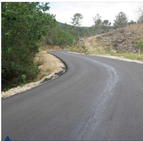
Pavimentação de via Manhouce
