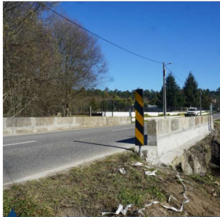
Reparação da vedação pontão rio varoso Carvalhais
