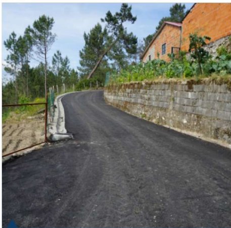
Pavimentação do caminho do rio Pesos - Sul
