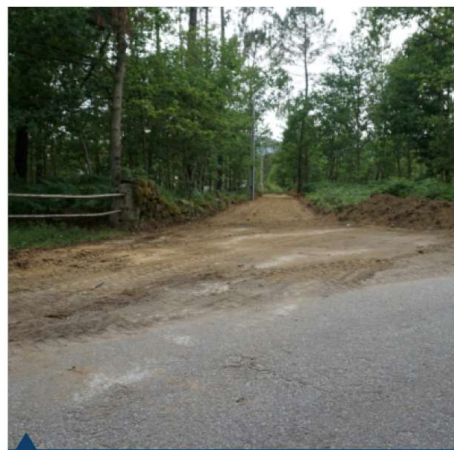
Pavimentação da estrada de Penso - Serrazes a Passos - Carvalhais
