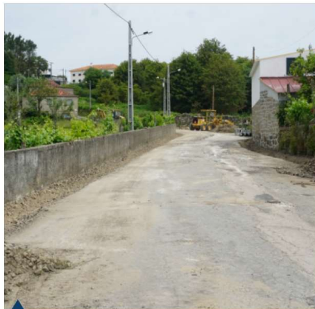
Pavimentação de via Novais - S. Pedro do Sul
