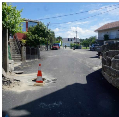
Saneamento e abastecimento de água Fermontelos
