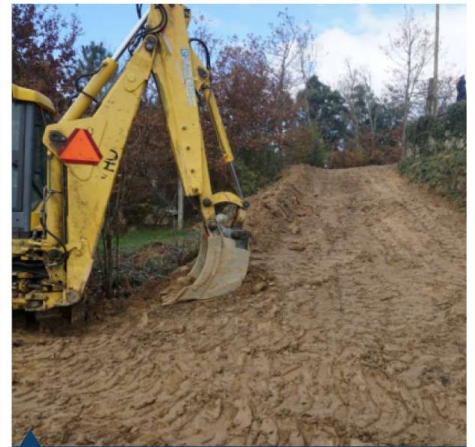
Reparação piso em Germinade Carvalhais
