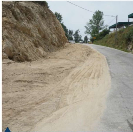
Alargamento de estrada S. Pedro do Sul - Pinho
