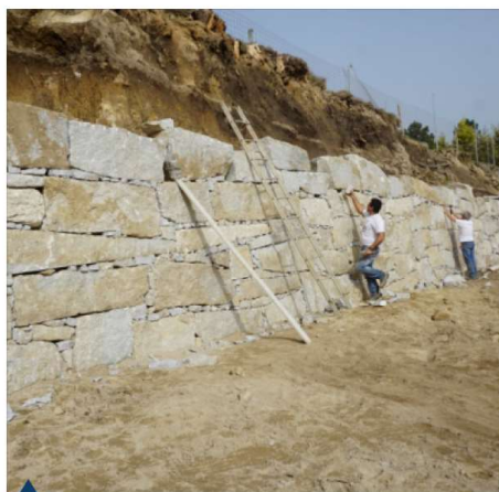
Construção de muro Santa Cruz da Trapa
