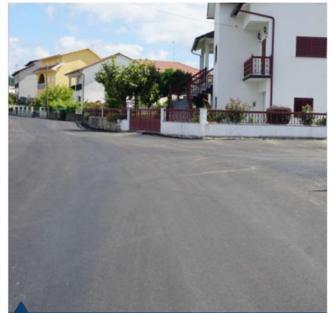
Pavimentação da estrada de Pindelo dos Milagres ao Sobral
