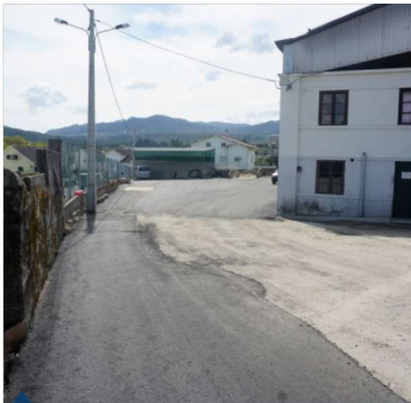
Requalificação armazéns Vieira da Cruz S. Pedro do Sul
