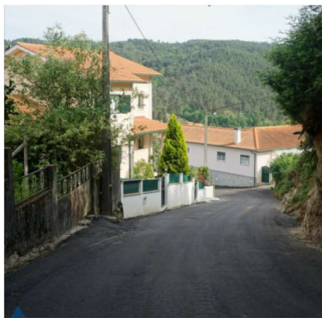
Pavimentação da estrada Oliveira-Trigal Sul
