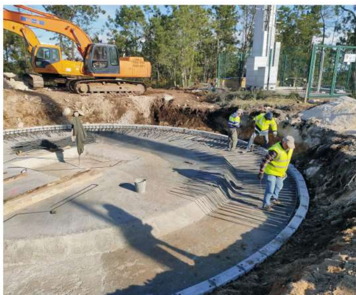
Construção de depósito de água Vila Maior
