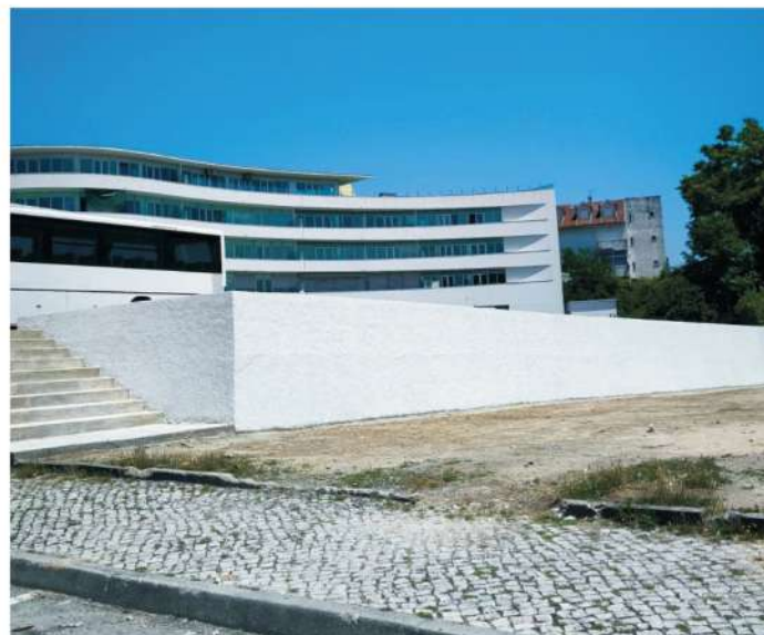
Construção de muro Recinto da Feira São Pedro do Sul
