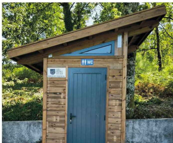
Instalação de WC - Parque de Merendas Bordonhos
