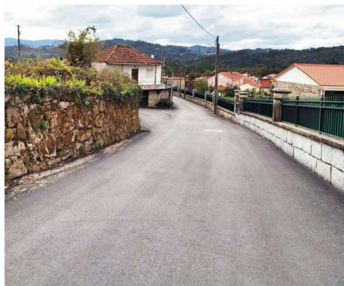
Pavimentação de via - Sacados São Félix
