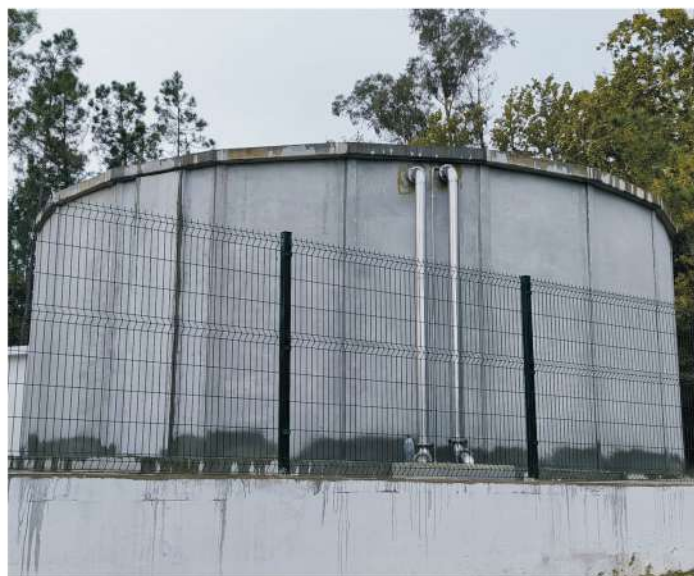
Construção de depósito de água - Cotos São Pedro do Sul
