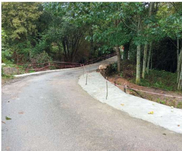
Requalificação da ponte da Rua da Escola Pinho (Em colaboração com a junta de Freguesia)
