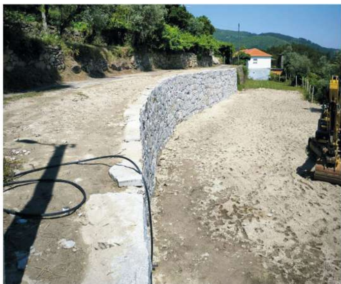
Construção de muro - Paradela Valadares
