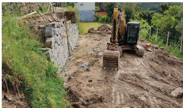
Construção de muro em Paradela Valadares
