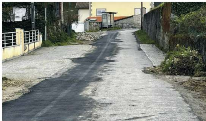
Execução da rede de saneamento no Cachamuço Carvalhais
