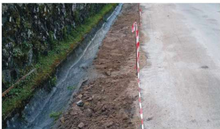
Expansão da rede de abastecimento público de água Penso Serrazes
