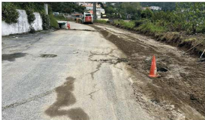
Reforço da água e saneamento Valadares
