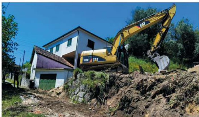
Alargamento de via - Outeiro Sul
