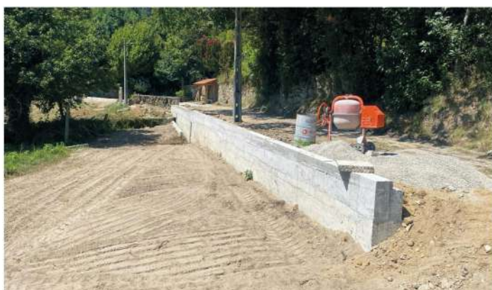
Construção de muro de suporte - Lágua - Baiões Colaboração com a U. F. S. Pedro do Sul Várzea e Baiões
