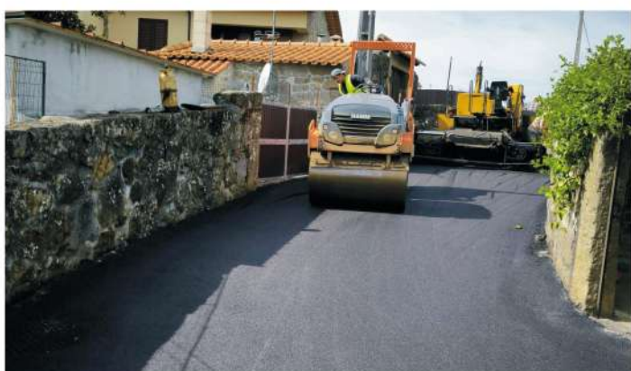
Requalificação de diversos arruamentos Serrazes
