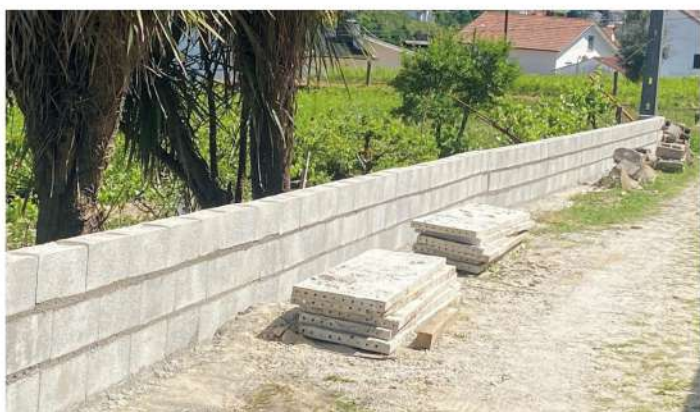
Reconstrução de muro de suporte - Pouves em colaboração com a U. F. de S. Pedro do Sul Várzea e Baiões
