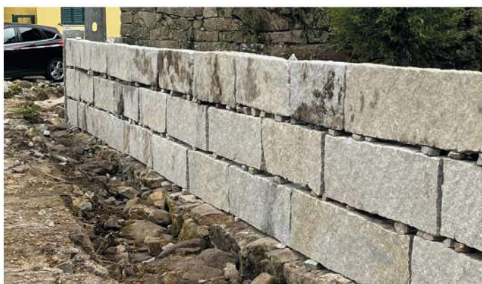
Alargamento de via - Rua da Calçada - Fermontelos em colaboração com a Junta de Freguesia de Figueiredo de Alva
