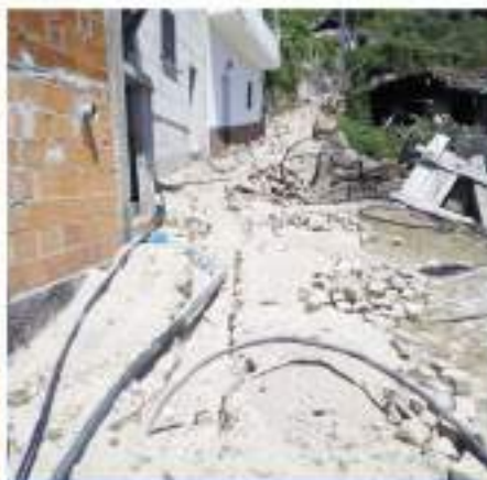
Abastecimento de água - Covelinhas S. Martinho das Moitas
