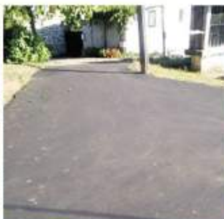
Pavimentação - Pedreira Valadares
