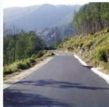
Pavimentação - Estrada do Carregal Manhouce
