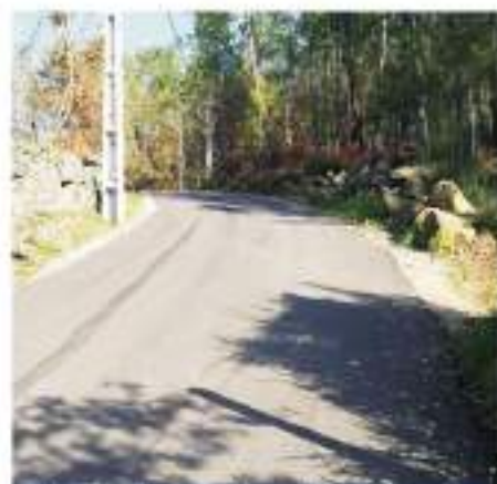
Pavimentação - Regueira S. Pedro do Sul
