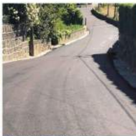
Pavimentação - Reguengo Carvalhais
