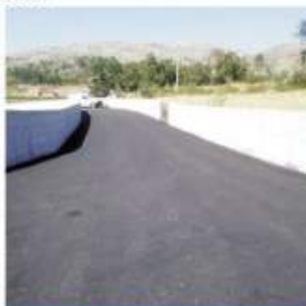
Pavimentação - Gestoso Manhouce
