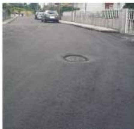
Pavimentação Bairro Belo Horizonte S. Pedro do Sul
