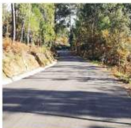
Pavimentação Estrada de Mosteirinho Pinho
