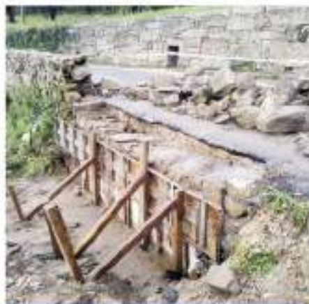
Construção de muros de apoio Estrada de Serrazes
