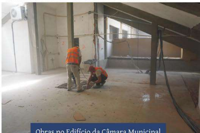
Obras no Edifício da Câmara Municipal
