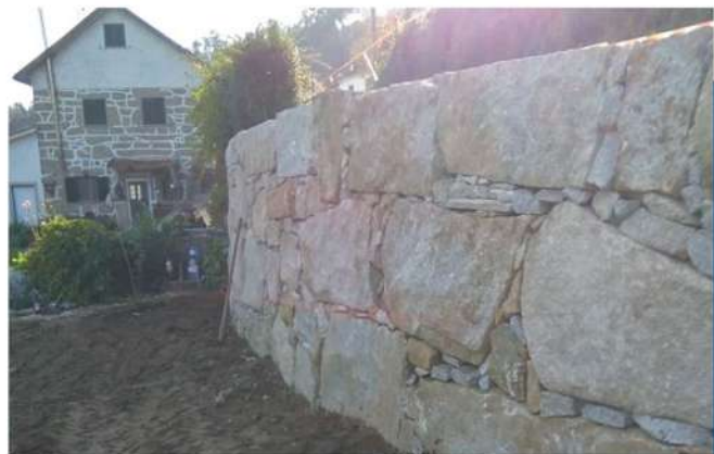
Construção de Muro Ribas - Carvalhais
