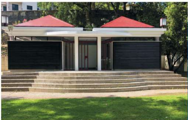
Requalificação de Casas de banho públicas Termas - S. Pedro do Sul
