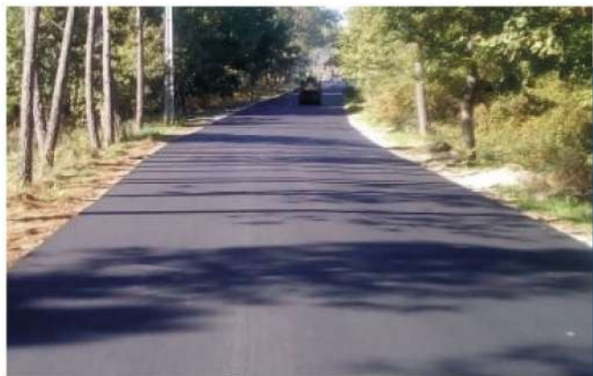
Pavimentação Souto de Ufo - Vila Maior
