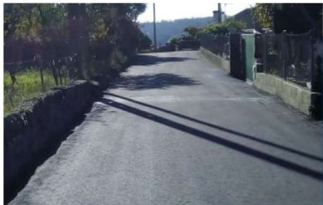
Pavimentação Amieiros - Pinho
