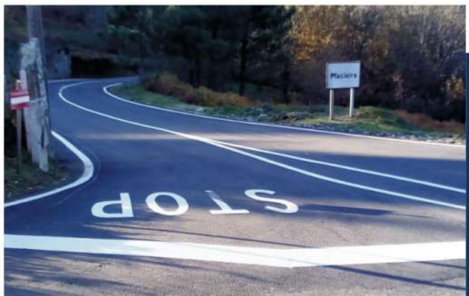
Pavimentação Macieira - Sul
