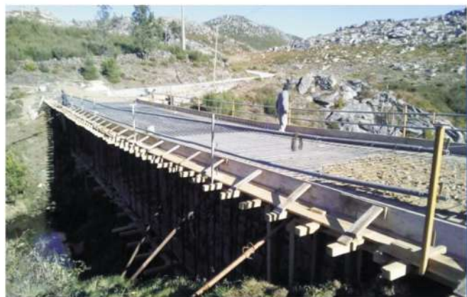
Construção de ponte Gestosinho - Manhouce
