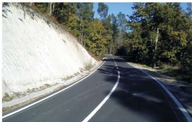
Pavimentação Estrada Cruzamento Lageosa e a Cruz do Braceiro S. Martinho das Moitas
