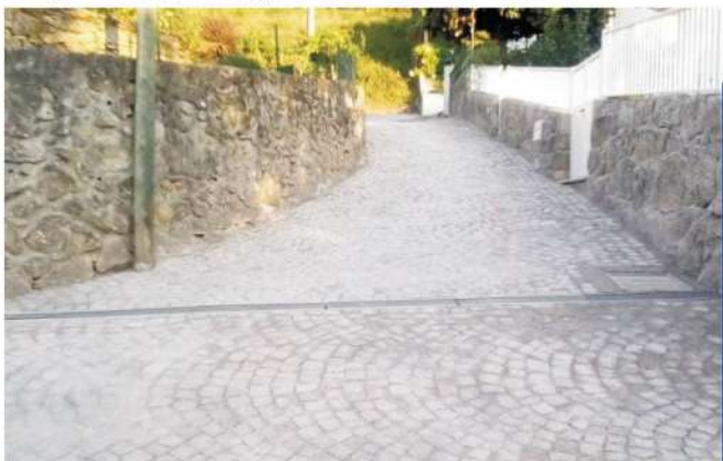
Calçetamento Rua da Costa Negrelos - S. Pedro do Sul
