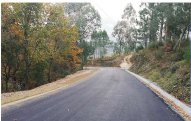
Pavimentação da Estrada Rio de Mel - Pindelo dos Milagres
