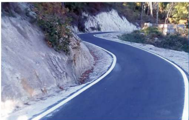
Pavimentação Santo Estevão - S. Martinho das Moitas
