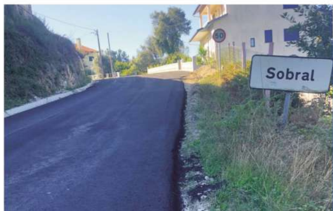
Pavimentação da Estrada Sobral - Mosteirinho - Pinho
