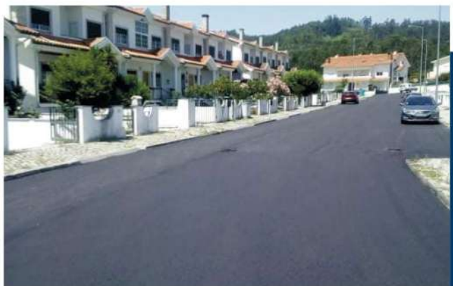
Pavimentação Quinta de Várzea - S. Pedro do Sul
