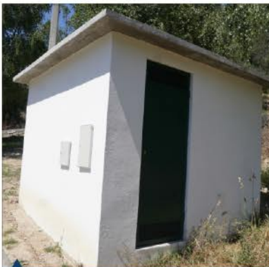
Abastecimento de Água - Barreira Manhouce
