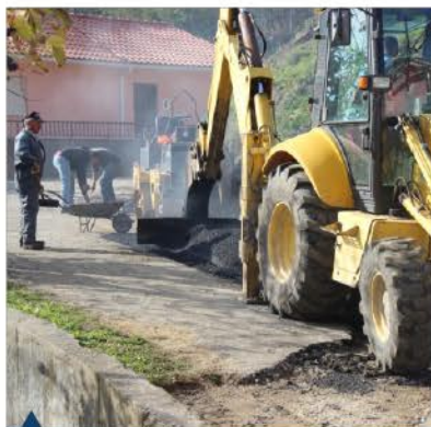
Pavimentação - Trigal Sul
