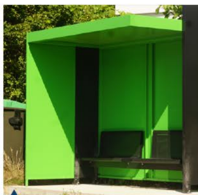
Substituição de abrigos na EN16 e EN 228
