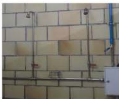
Substituição da tubagem de águas sanitárias no Complexo Desportivo Municipal anulando a fuga de 2m 3 de água quente por hora
