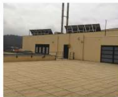
Limpeza e pequenas obras no Complexo Desportivo Municipal tornando-o mais agradável
