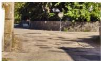
Reparação de piso Reguengo - Carvalhais
