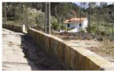
Construção de muro Sobral - Pinho
