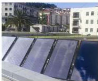
Instalação de painéis solares no Complexo Desportivo Municipal aumentando a sua eficiência energética
