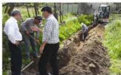
Ampliação do ramal de abastecimento de água no Gramol - Valadares
