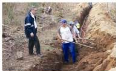
Construção de ramal de abastecimento de água - Manhouce
