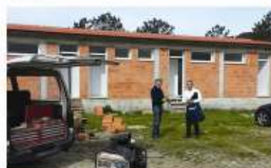
Acabamento dos interiores - Balneários Manhouce
