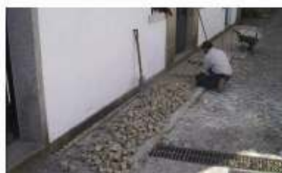
Calçetamento e pinturas nas Termas de S. Pedro do Sul
