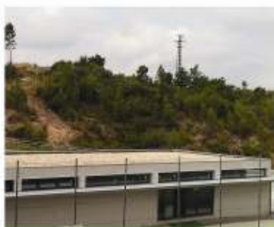
Instalação de equipamento de aquecimento de água nos balneários do Estádio Municipal , permitindo a sua utilização
