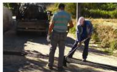
Reparação de piso Casal - S. Félix
