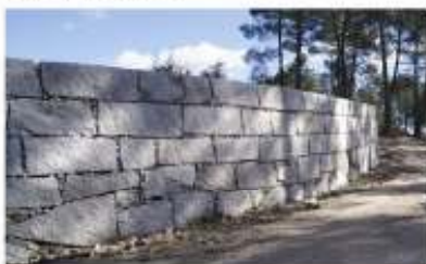
Alargamento de caminho Fermontelos - Figueiredo de Alva
