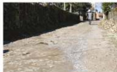
Construção de conduta para abastecimento de água - Freixo - Serrazes
