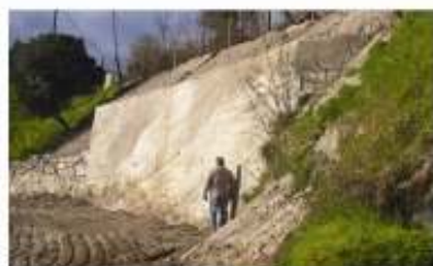
Construção de muro Amoreira - Sul
