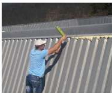
Intervenção na cobertura do Pavilhão da Lameira anulando infiltrações de água, que impediam a sua utilização em dias chuvosos
