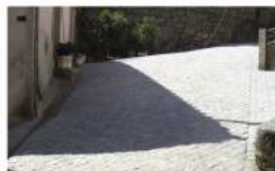
Calçetamento na Travessa de S. Bernardo - S. Pedro do Sul
