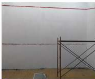
Obras de recuperação da Sala de Squash , já aberta ao público
