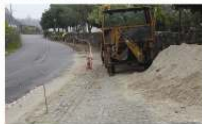
Reparação de calçada Igreja - Pinho
