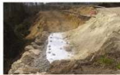
Construção de muro Covelas - Serrazes
