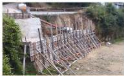
Construção de muro de suporte Mosteirinho - Pinho
