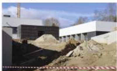
Finalização Obra Pólo Escolar S. Pedro do Sul
