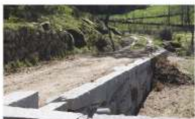
Construção de muro Igreja - Figueiredo de Alva
